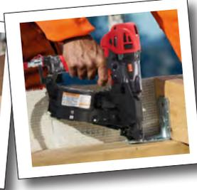
Befestigung von Balkenschuhen und Nagelplatten.
