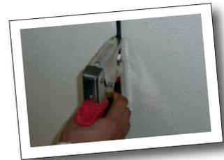
Befestigung von Kabel Ø 6 mm
