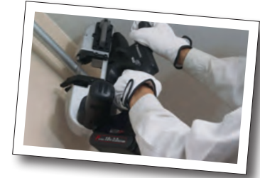
Travaux généraux, installations électriques et sanitaires.
