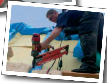
Pour une fixation pneumatique à haute pression jusqu'à 23 bars. Toit. Encadrement de plancher, mur...
